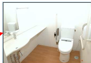
様式トイレ・洗面台 （手摺設置）
